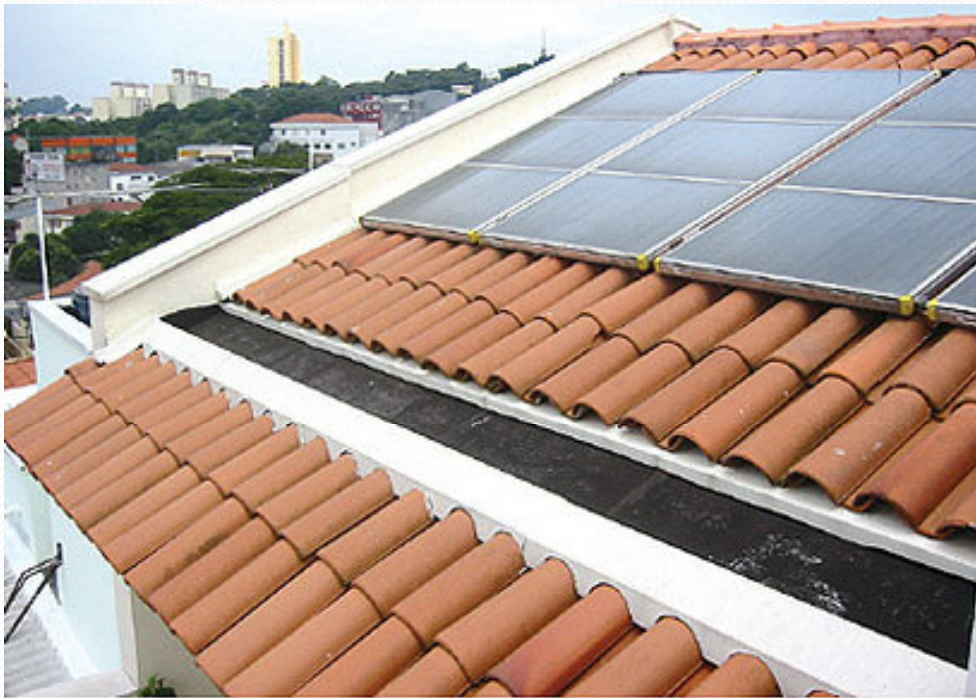
Figura 1 – Calha coletora situada em posição intermediária permitindo alimentação do reservatório superior de água pluvial por gravidade
